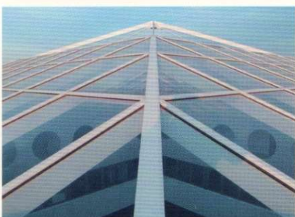
48 PARETI DI VETRO di Manuela Fiorotto
